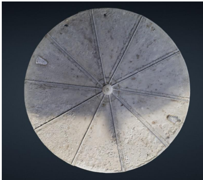
Ombre portée sur le toit de la colonne des douves, causée par l'ensoleillement lors de la prise de vues.
