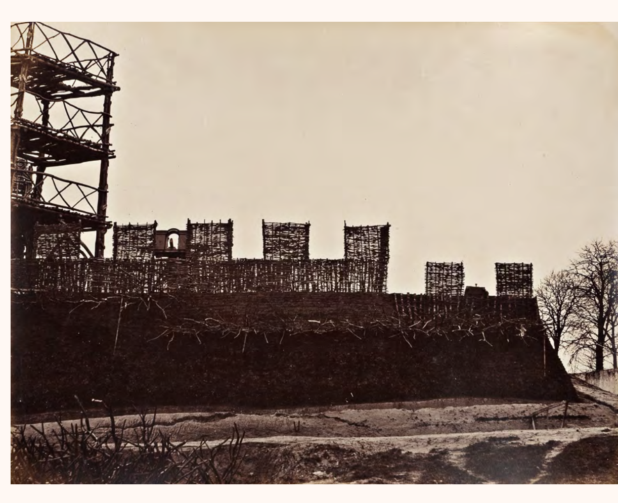
● Les travaux du siège d'Alésia à Meudon. Epreuve photographique sur papier albuminé. MAN, centre des archives, Albums blanc n°5, pl. 291.
