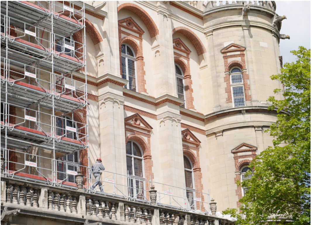
Travaux de restauration du château, façade sud, 2015.
